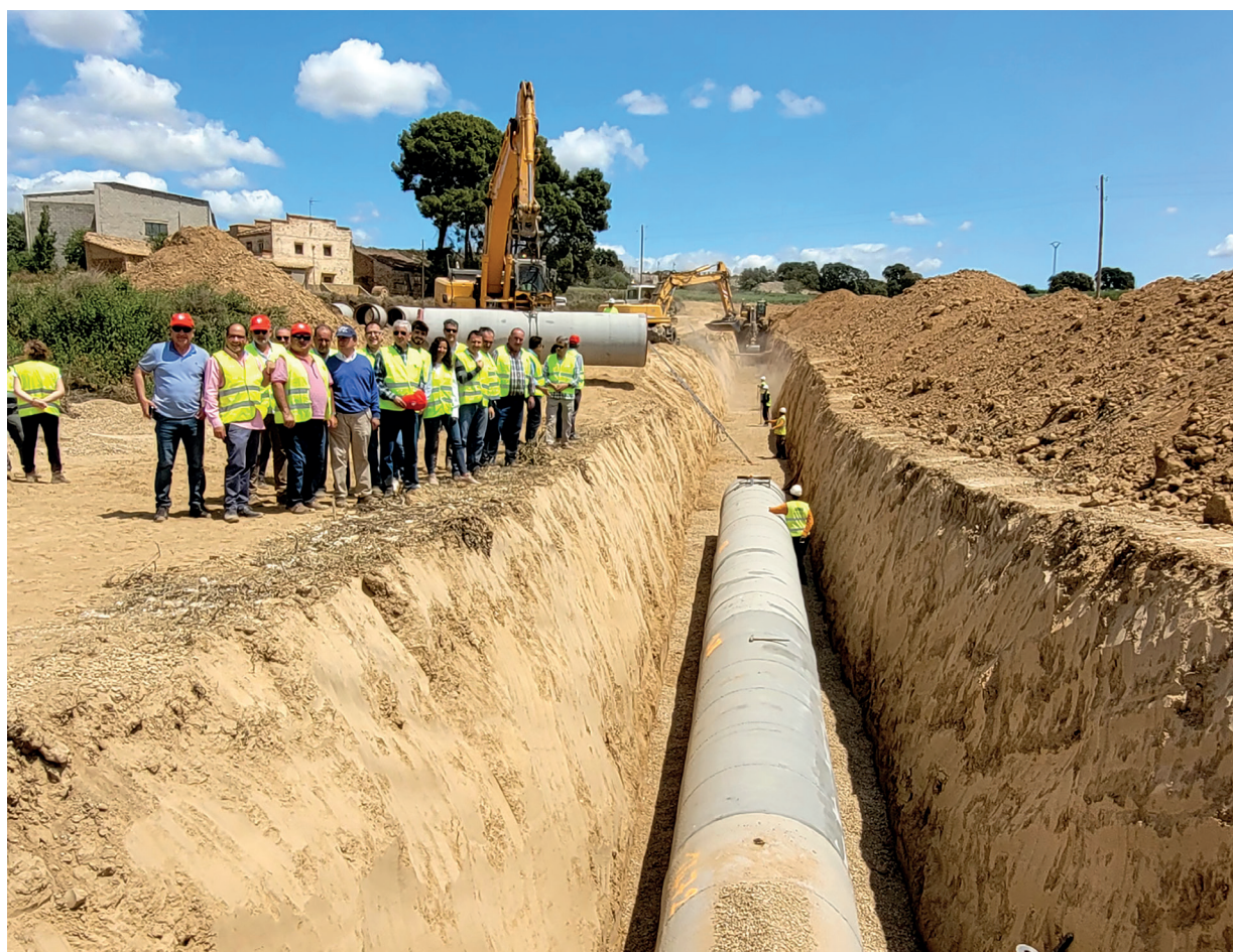
Tamarite de Litera, 11 · Mayo · 2023 Visita JG estado de las obras variante Tubería de La Mola
