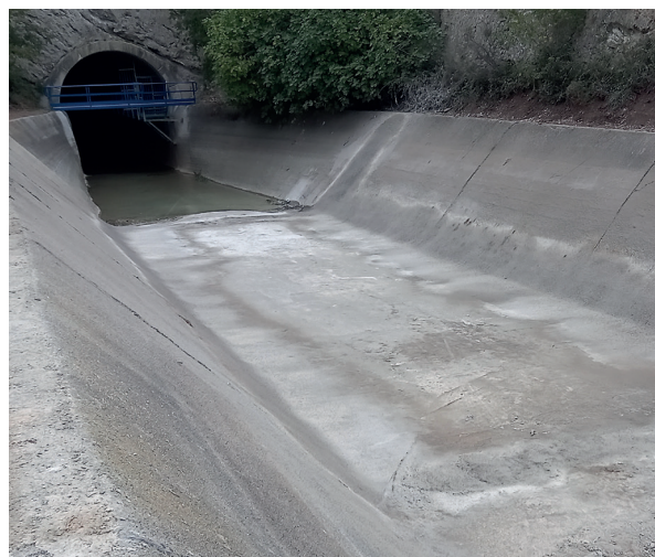
25 · Octubre · 2023 Primera fase: Demolición de solera existente, saneo, consolidación, nueva solera y sellado, contacto e inyección general de toda la solera
