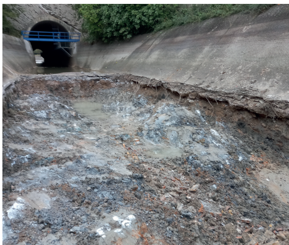
25 · Octubre · 2023 Primera fase: Demolición de solera existente, saneo, consolidación, nueva solera y sellado, contacto e inyección general de toda la solera
