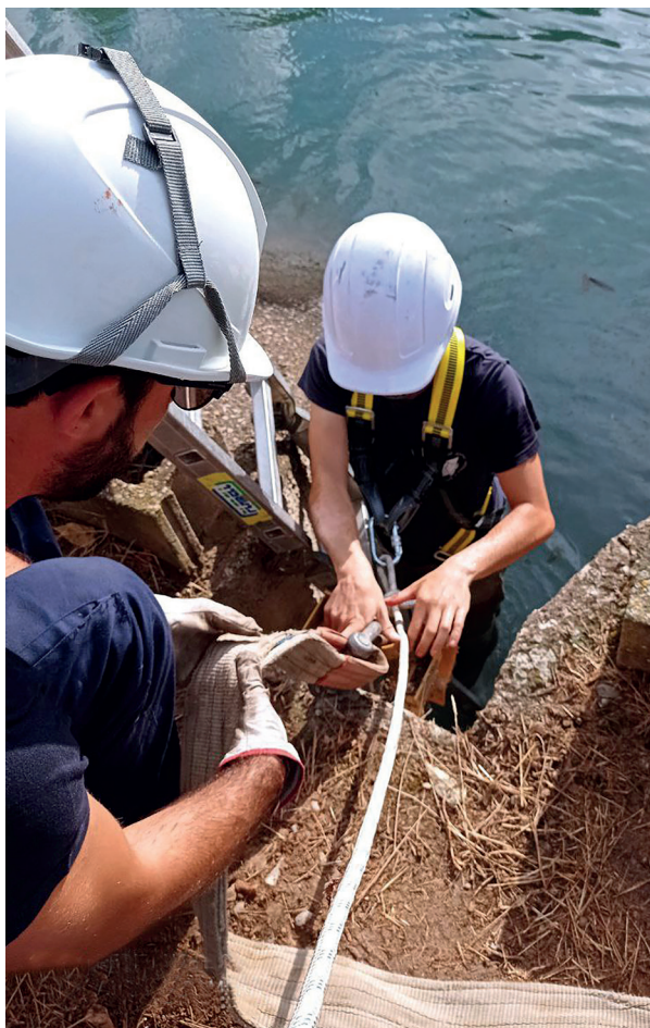
Reparación compuerta de toma
