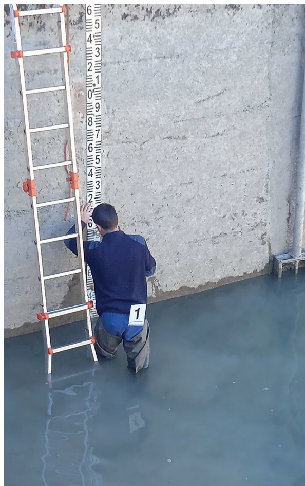
Colocación de escalas
