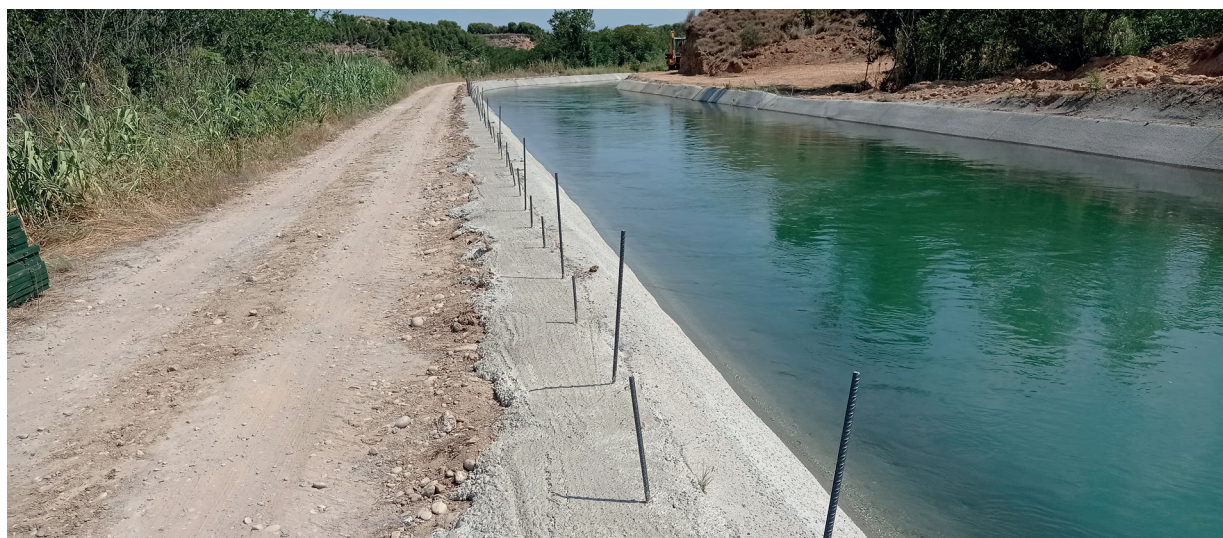
Recrecimiento en el PK 73,2 del Canal Principal
